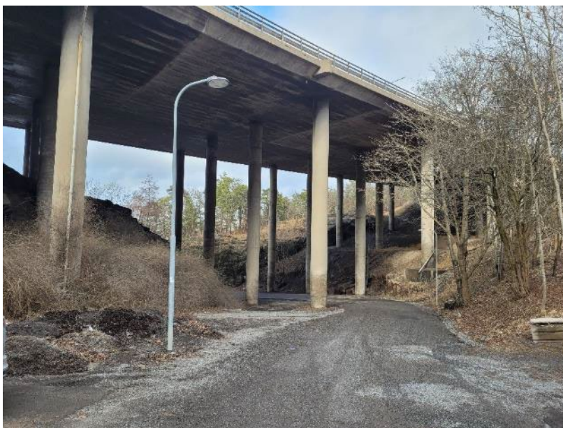
Figur 12. Område där Ryssviksvägen passerar under Värmdöleden (notera stuprör från Värmdöleden), en teknisk reningsenhet kan anläggas under mark.
